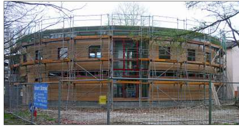
Umzug vor acht Jahren: Unser Archivbild zeigt den Rundbau kurz vor der Fertigstellung 2006. – Fotos: fam
